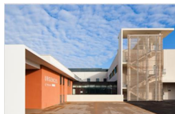
Peintures intérieures et extérieures
